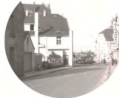
ehemalige Kirchhofstraße 2 - 8 (Fotoaufnahme von 1957)
