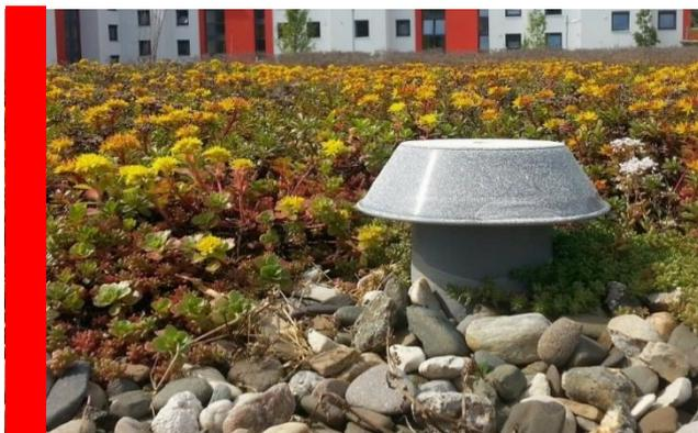
*Eine Dachbegrünung hält bei Starkregen Wasser zurück und sorgt bei Hitze für Temperatenausgleich.*
